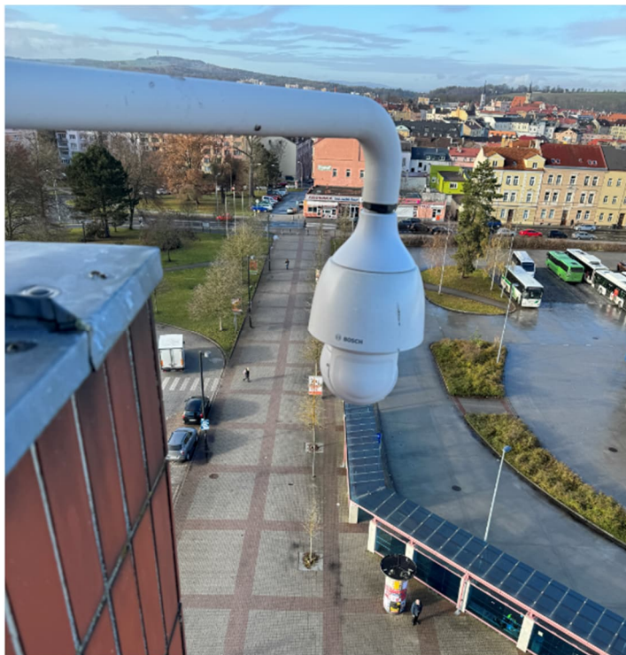
Obrázek 2: Kamera MP na výložíku [foto V. Mašek]
