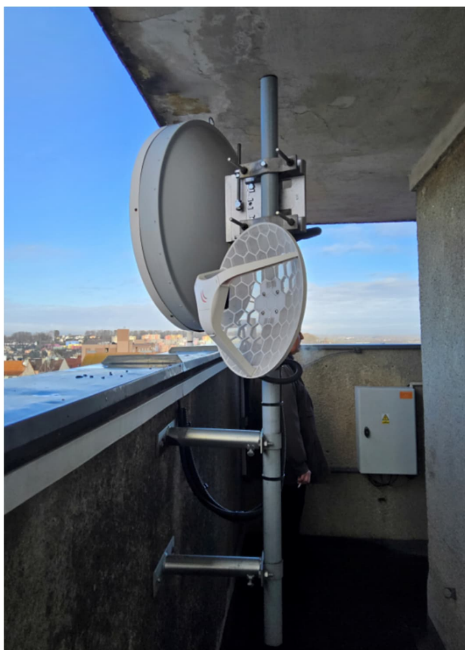
Obrázek 3: Instalovaná mikropojítka MP Cheb, v pozadí rozvaděč kamerového bodu [foto E. Střelka]
